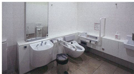
トイレ、汚物処理室
