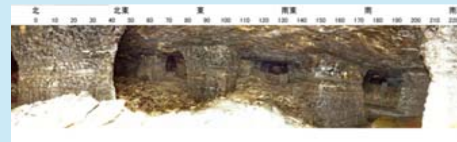
空洞カメラによる地下空洞の画像
